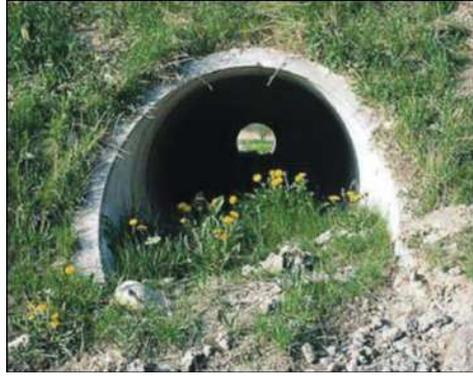
**Exemple de passage inférieur à petite faune (type buse)**
