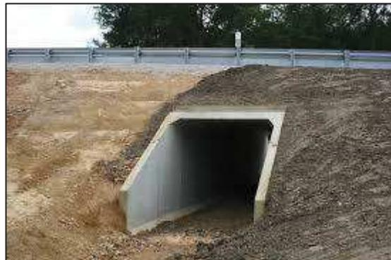
**Exemple de passage inférieur à moyenne faune (type pont cadre)**
